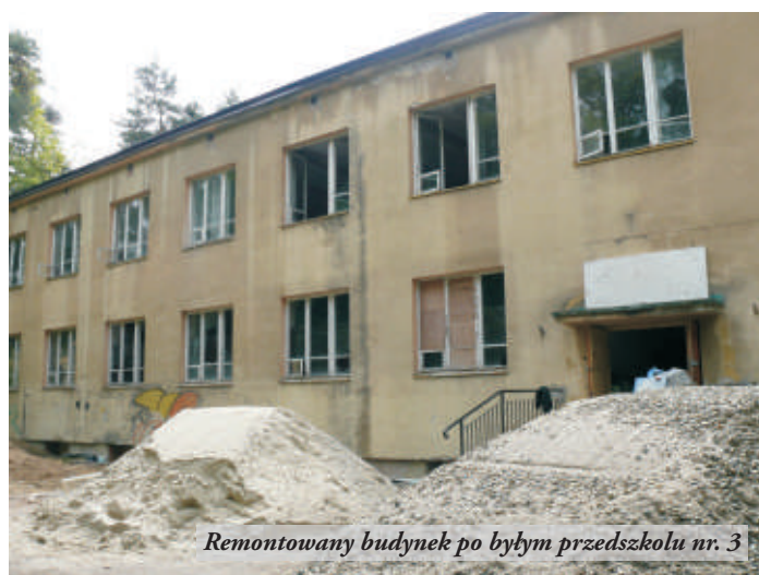
Pierwsze prace związane z tyczeniem sieci kanalizacyjnej w Łętowni-Gościńcu
