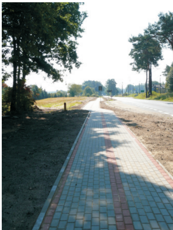
Zakończono 3. etap budowy ścieżki pieszo-rowerowej
