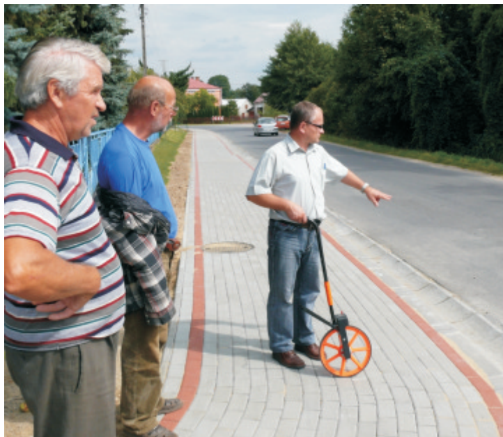
Odbiór nowego chodnika w Łętowni (na wys. Domu Kultury)
