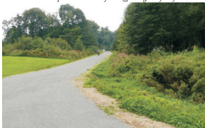
Nowa droga w Łętowni
