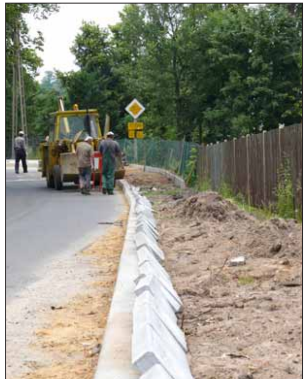
Budowa chodnika w Woli Zarczyckiej fot. bw
