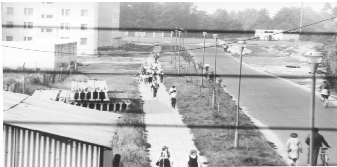
Budowa Sójczego Wzgórza ok. 1987 r. Fot. Edward Karaś, arch. cyfr. CKiB w Nowej Sarzynie
