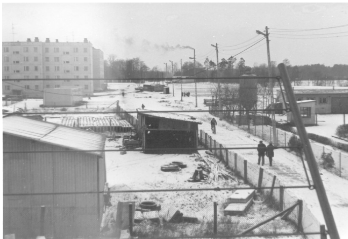
Budowa Sójczego Wzgórza ok. 1983 r. Fot. Edward Karaś, arch. cyfr. CKiB w Nowej Sarzynie
