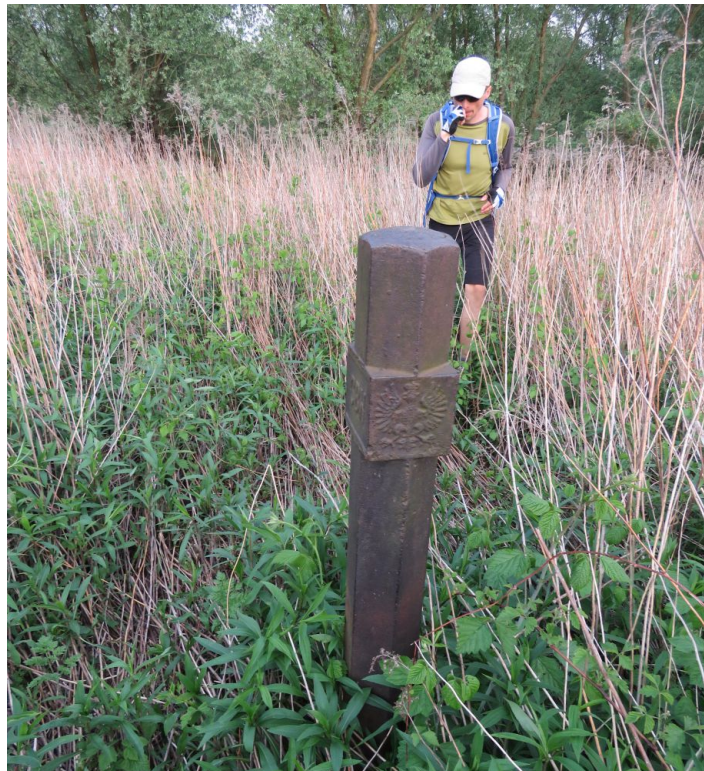
Żelazny reper wodowskazowy osadzony przez CBH w 1930 roku, fot. J. Motyka
