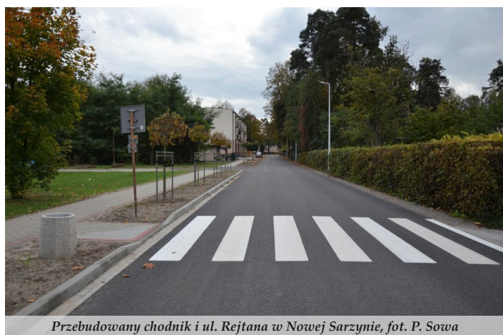
Przebudowany chodnik i ul. Rejtana w Nowej Sarzynie, fot. P. Sowa
