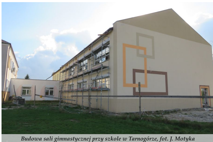
Budowa sali gimnastycznej przy szkole w Tarnogórze, fot. J. Motyka
