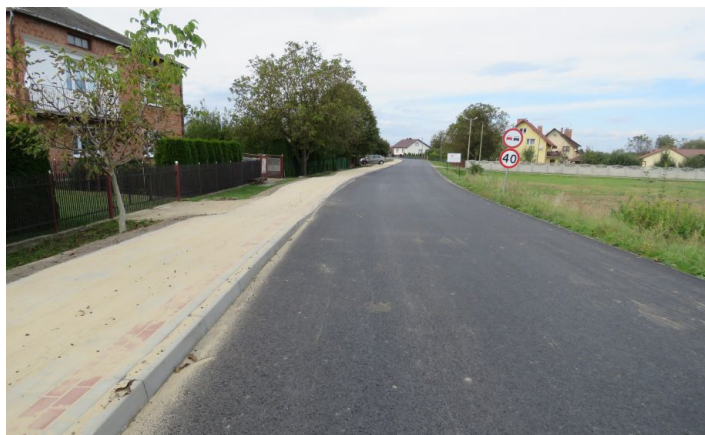
Nowa nawierzchnia drogi gminnej i chodnik „Za wodą” w Sarzynie, fot. J. Motyka
