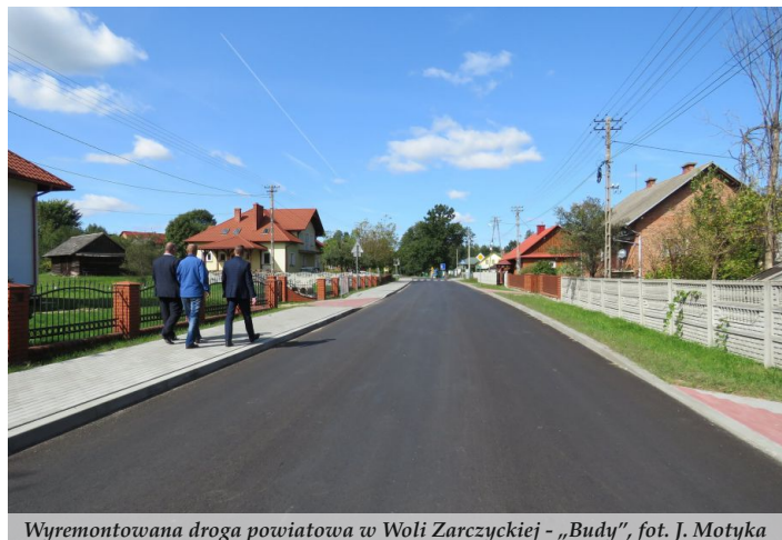
Wyremontowana droga powiatowa w Woli Zarczyckiej - „Budy”, fot. J. Motyka
