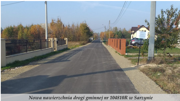
Nowa nawierzchnia drogi gminnej nr 104810R w Sarzynie
