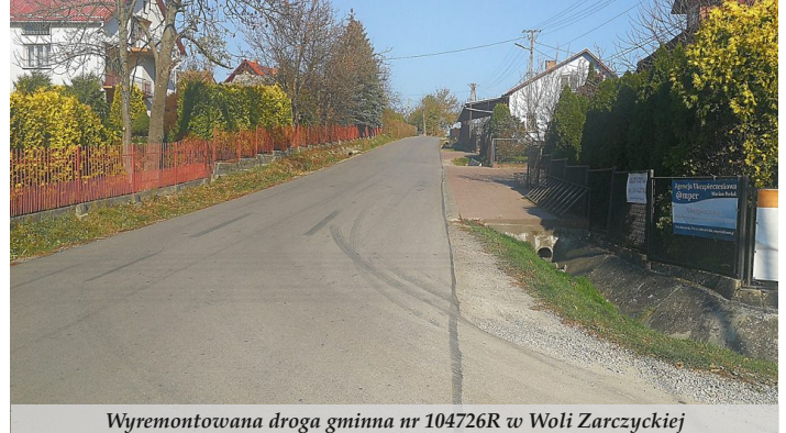
Wyremontowana droga gminna nr 104726R w Woli Zarczyckiej
