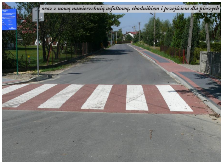
Droga w Sarzynie w trakcie remontu...
