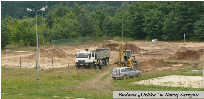
Budowa „Orlika” w Nowej Sarzynie
